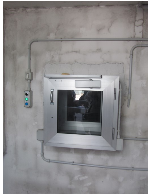
Fig. 02: Ingresso Nord – Pass box 1
