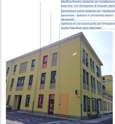
Modifica finestra esistente per installazione pass-box con formazione di bussola coperta
