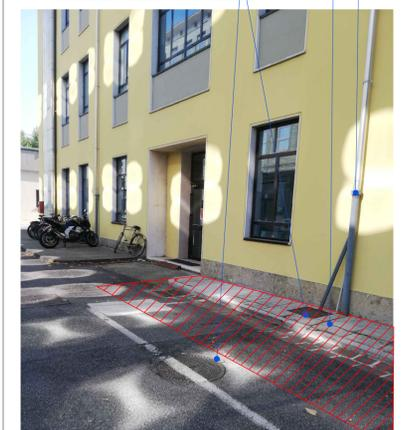
Intercettazione pluviale per formazione di vano ascensore con nuovo pluviale
