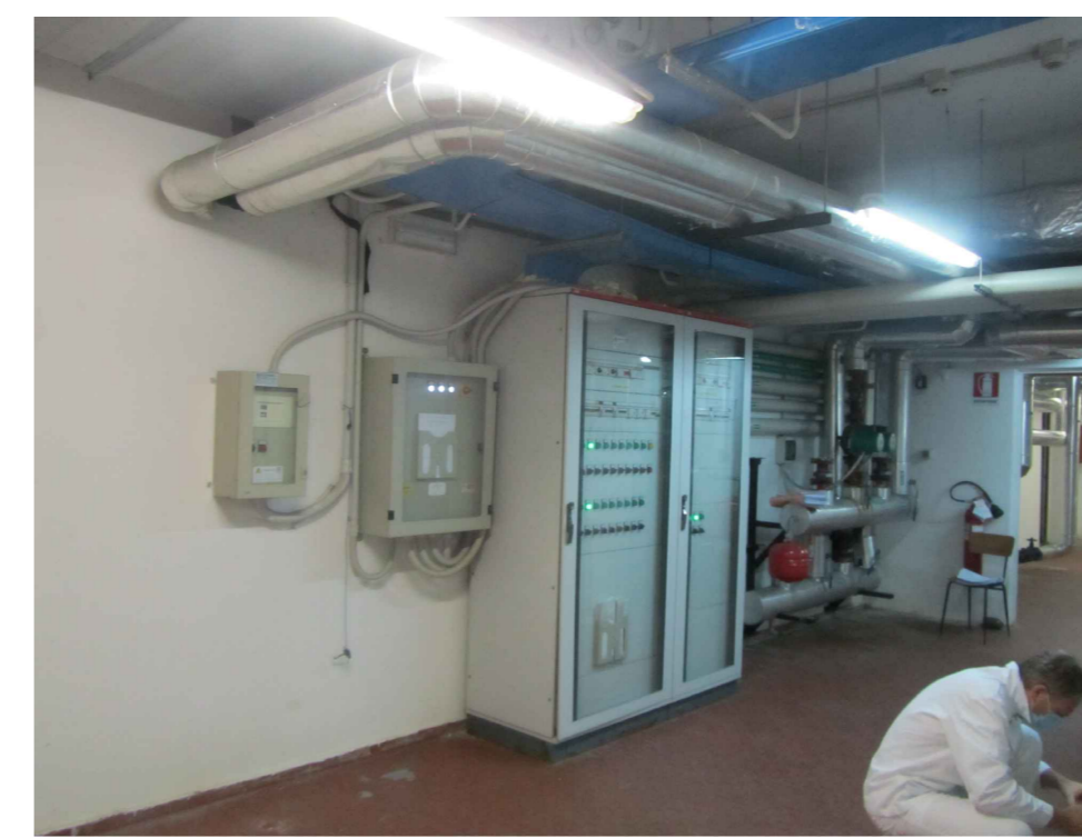
Vista 01 - Zona Q.E.
