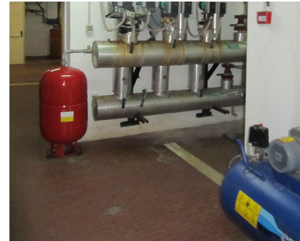
Vista 02 - Spazio tecnico esistente
