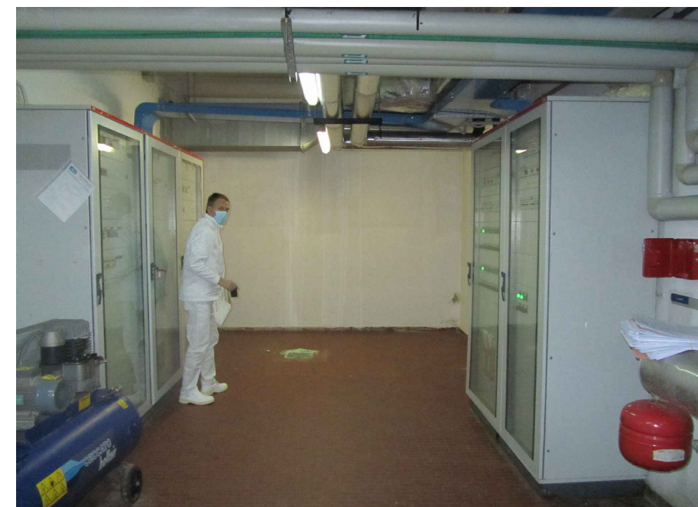
Vista 05 - Zona Q.E.
