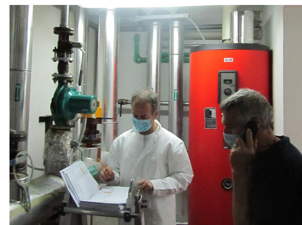
Vista 04 - Spazio tecnico esistente
