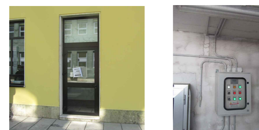
Vista 08 - Accesso Pass-Box
