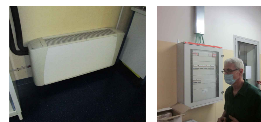
Vista 05 - Ventilconvettore
