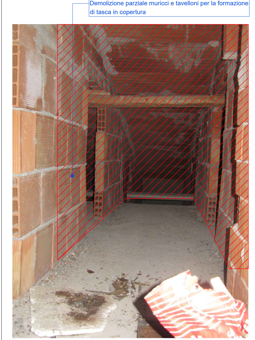
Vista 02 - Vista sottotetto in muricci e tavelloni oggetto di intervento
